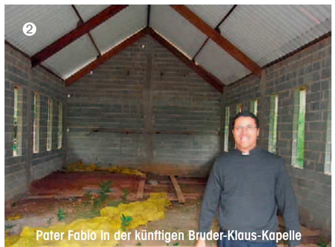
Bruder-Klaus-Kapelle im Rohbau
