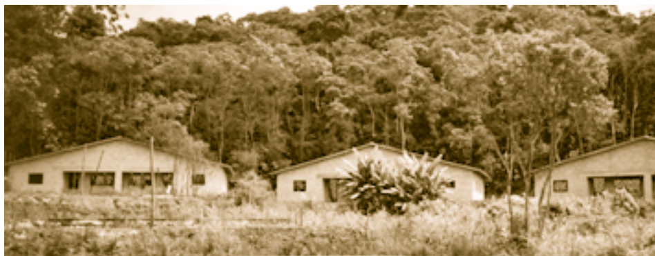
Die drei Doppelhäuser mit den Wohnungen 1-6 nach dem Baustop vom Januar.
