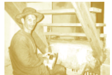
Mario Vieira beim Einbau der Holz- treppe vom 2. in den 3. Stock. Der vielseitige Handwerker gab seine Stelle auf und übernahm mit drei Kollegen den Hauptteil des Innen- ausbaus.
